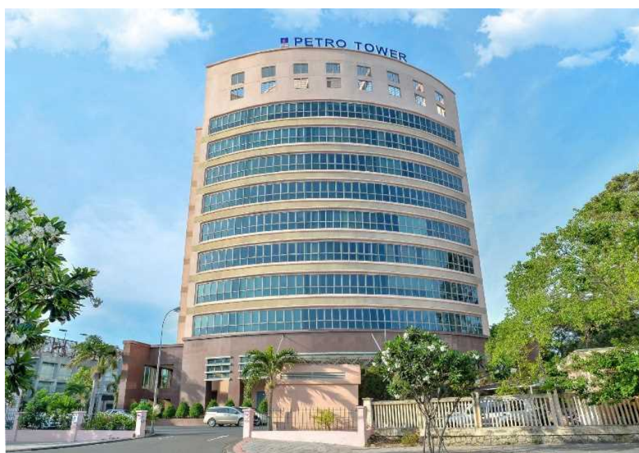
現在の日本ベトナム石油オフィス（PetroVietnam Tower）
