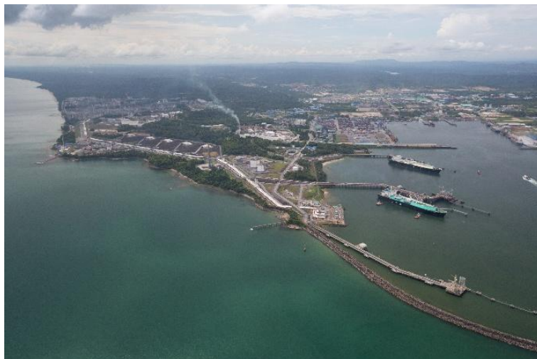
ビンツル LNG 基地（提供：ペトロナス）
